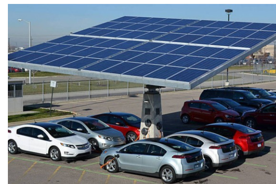
Estações de carregamento para veículos elétricos
